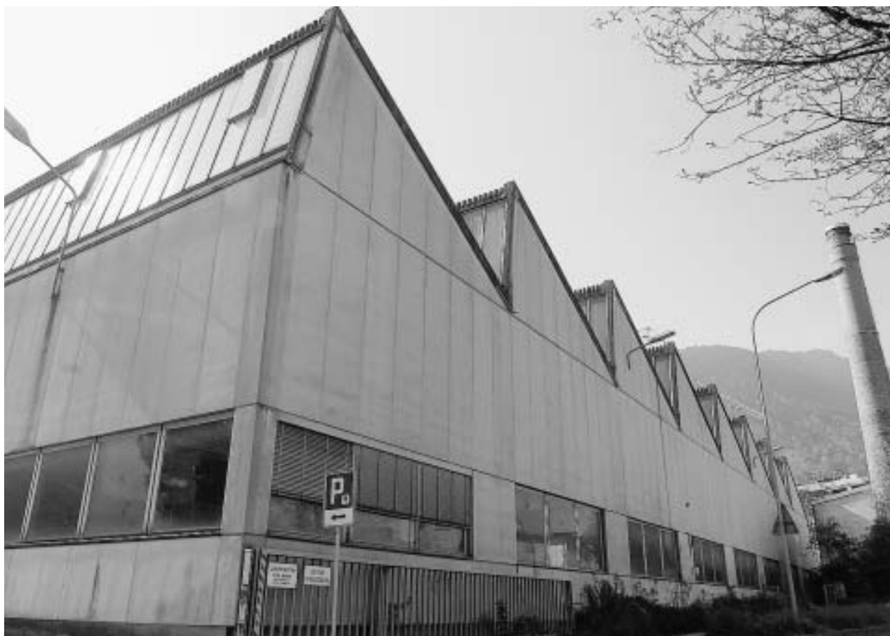
Sorgfalt ist nötig: Die Dachplatten der früheren SBB-Hauptwerkstätte müssen wegen Asbests demontiert werden, bevor das Gebäude abgebrochen werden kann.
